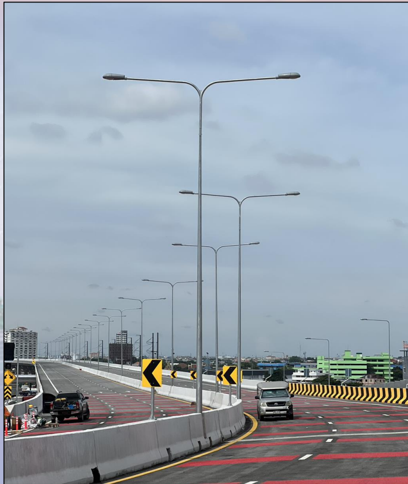
ภาพถ่ายงานติดตั้งเสาไฟถนนแบบกิ่งคู่
