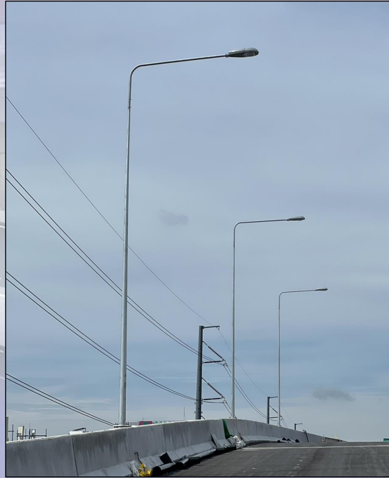
ภาพถ่ายงานติดตั้งเสาไฟถนนแบบกึ่งเดี่ยว
