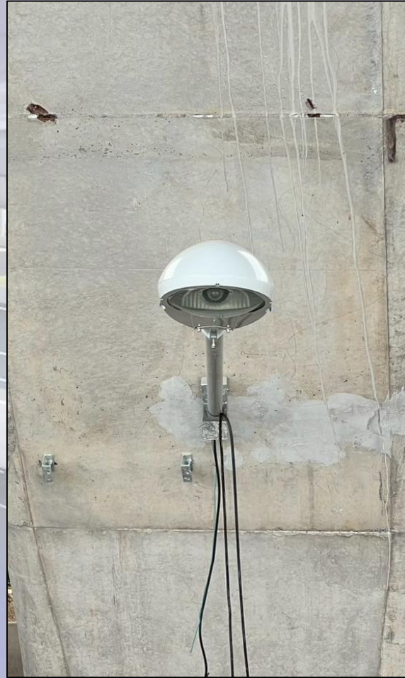
ภาพถ่ายงานติดตั้งเสาไฟถนนแบบกิ่งขาจับเสา Y
