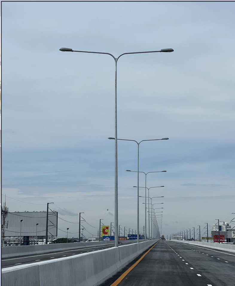
ภาพถ่ายงานติดตั้งเสาไฟถนนแบบกิ่งคู่
