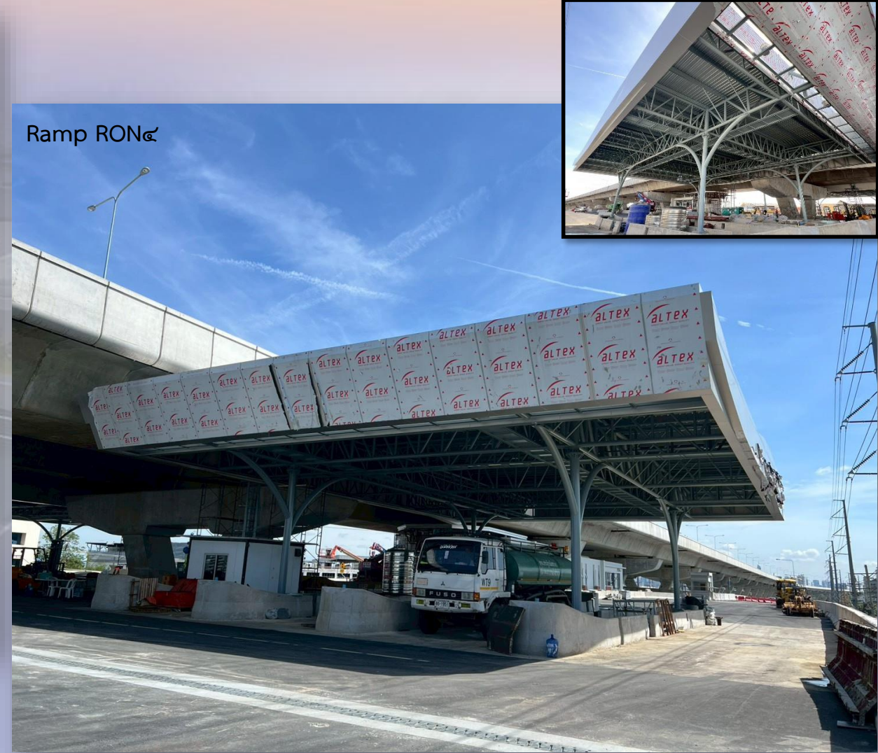
ภาพถ่ายงาน Canopy Structure - ด้านบางมด (Ramp 4)
