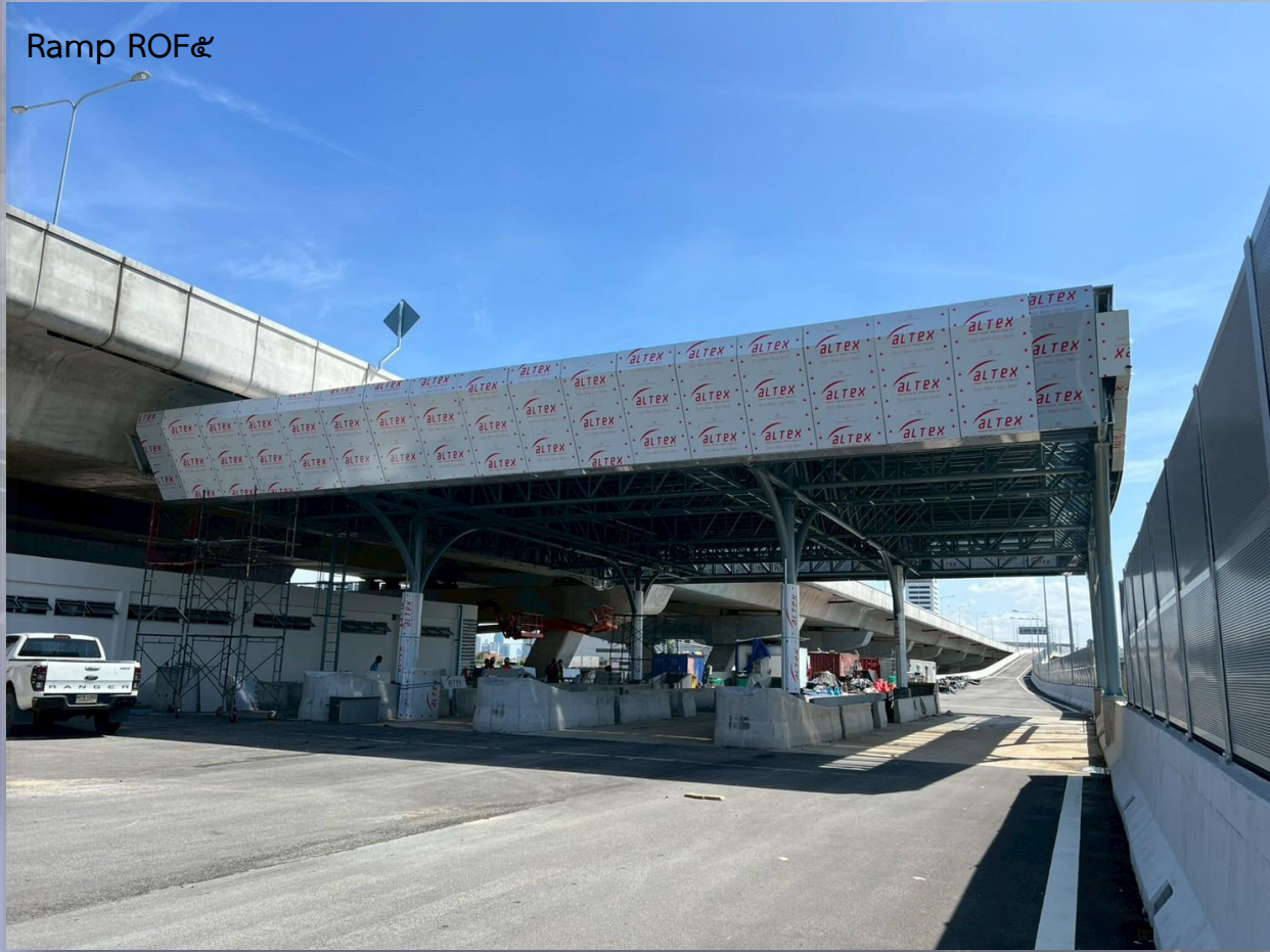
ภาพถ่ายงาน Canopy Structure – ด้านพุทธบูชา (Ramp 5)
