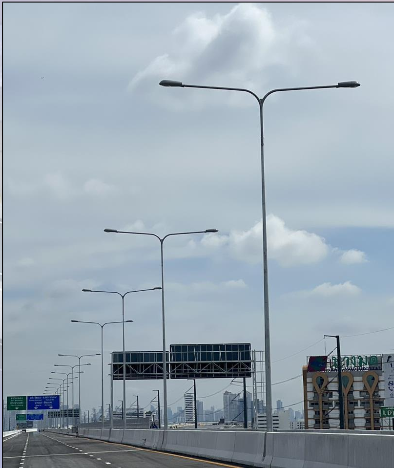
ภาพถ่ายงานติดตั้งเสาไฟถนนแบบกิ่งคู่
