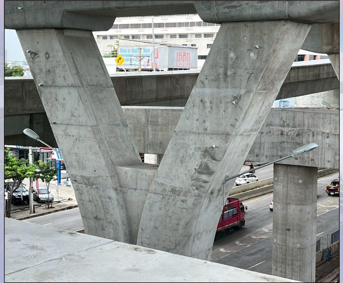
ภาพถ่ายงานติดตั้งเสาไฟถนนแบบกิ่งขาจับเสา Y
