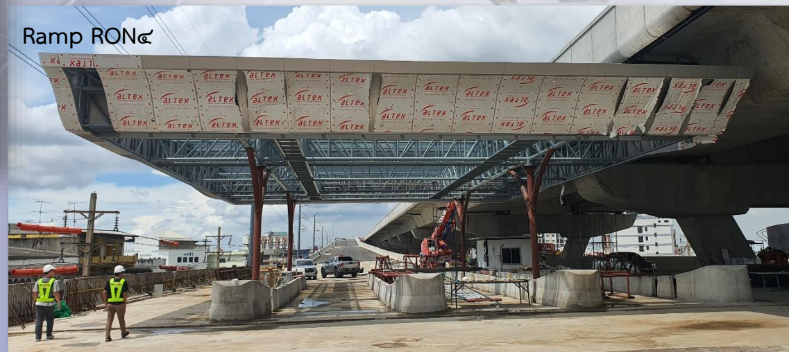
ภาพถ่ายงาน Canopy Structure – ด้านบางมด (Ramp 4)
