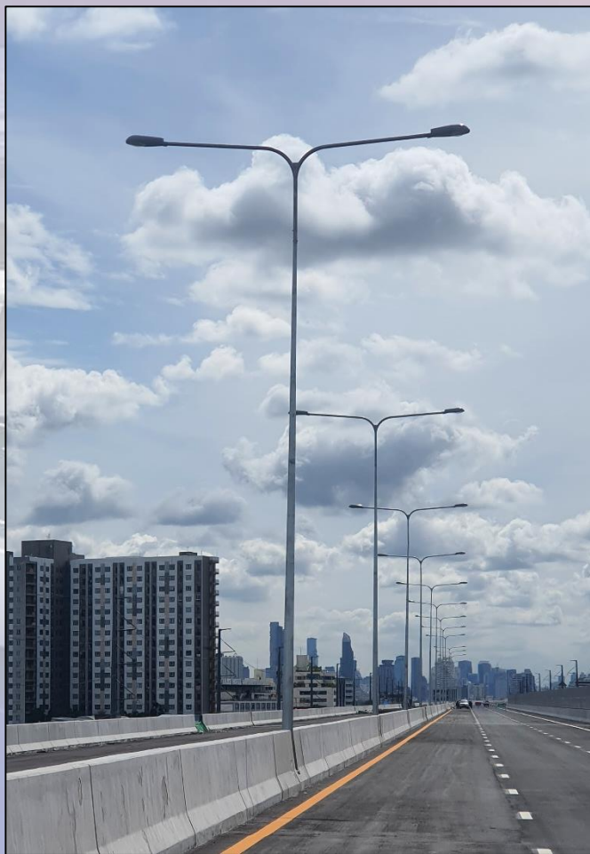
ภาพถ่ายงานติดตั้งเสาไฟถนนแบบกิ่งคู่
