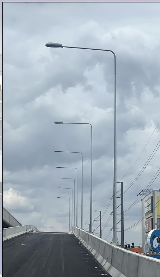
ภาพถ่ายงานติดตั้งเสาไฟถนนแบบกิ่งเดี่ยว
