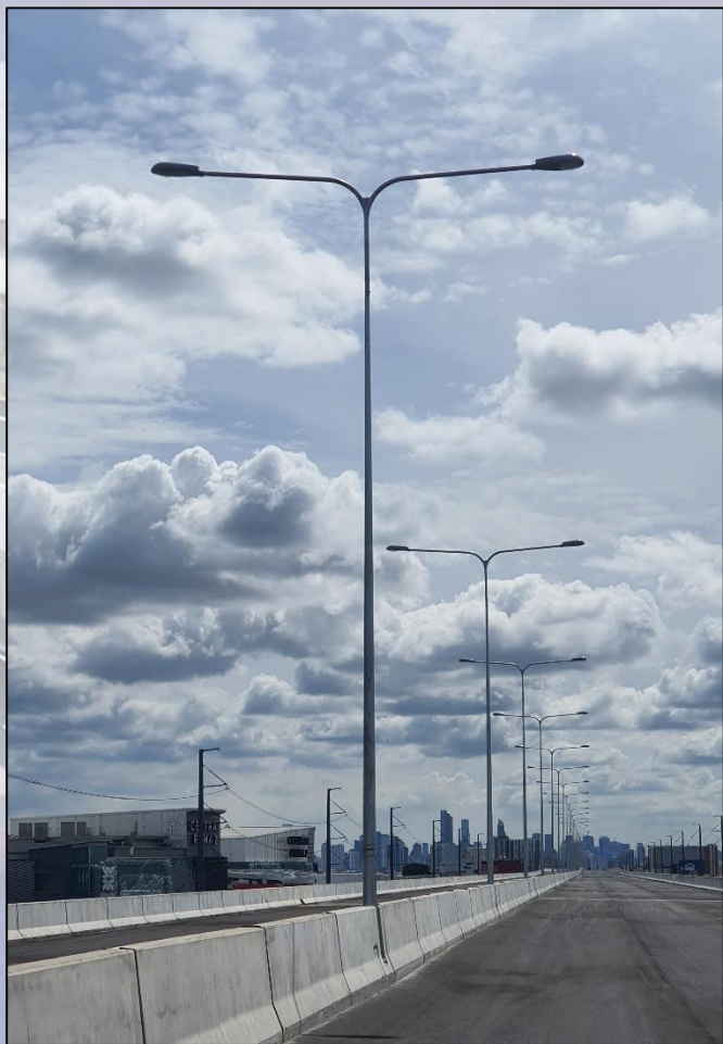
ภาพถ่ายงานติดตั้งเสาไฟถนนแบบกิ่งคู่
