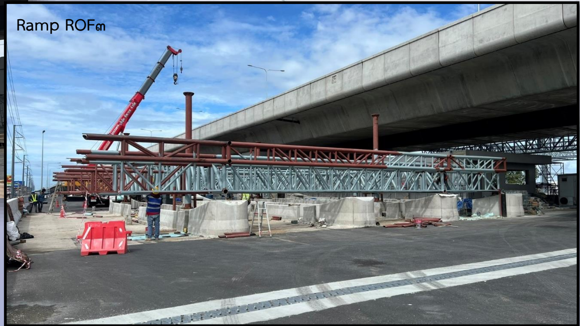
ภาพถ่ายงาน Canopy Structure – ด้านท่าข้าม (Ramp 3)
