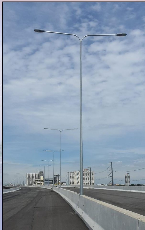
ภาพถ่ายงานติดตั้งเสาไฟถนนแบบกิ่งคู่
