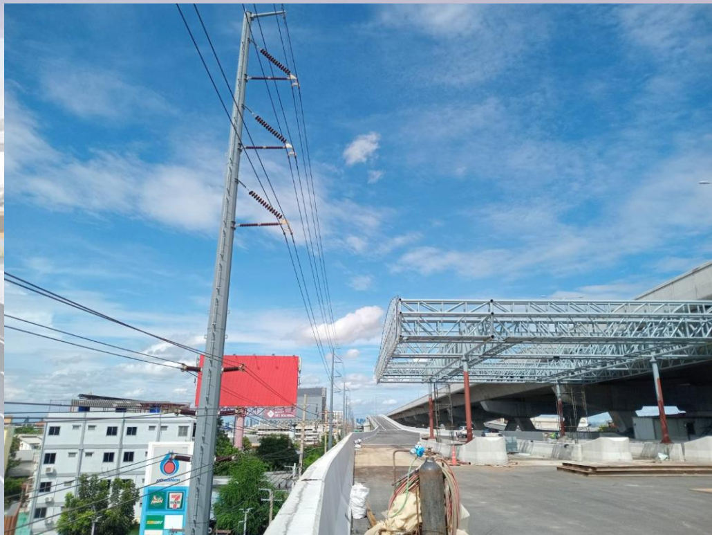
Toll Canopy Ramp๓ - ด้านวัดเลา
