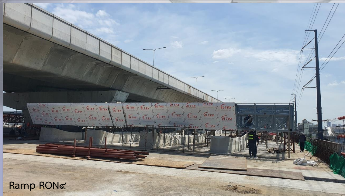
ภาพถ่ายงาน Canopy Structure – ด้านบางมด (Ramp 4)
