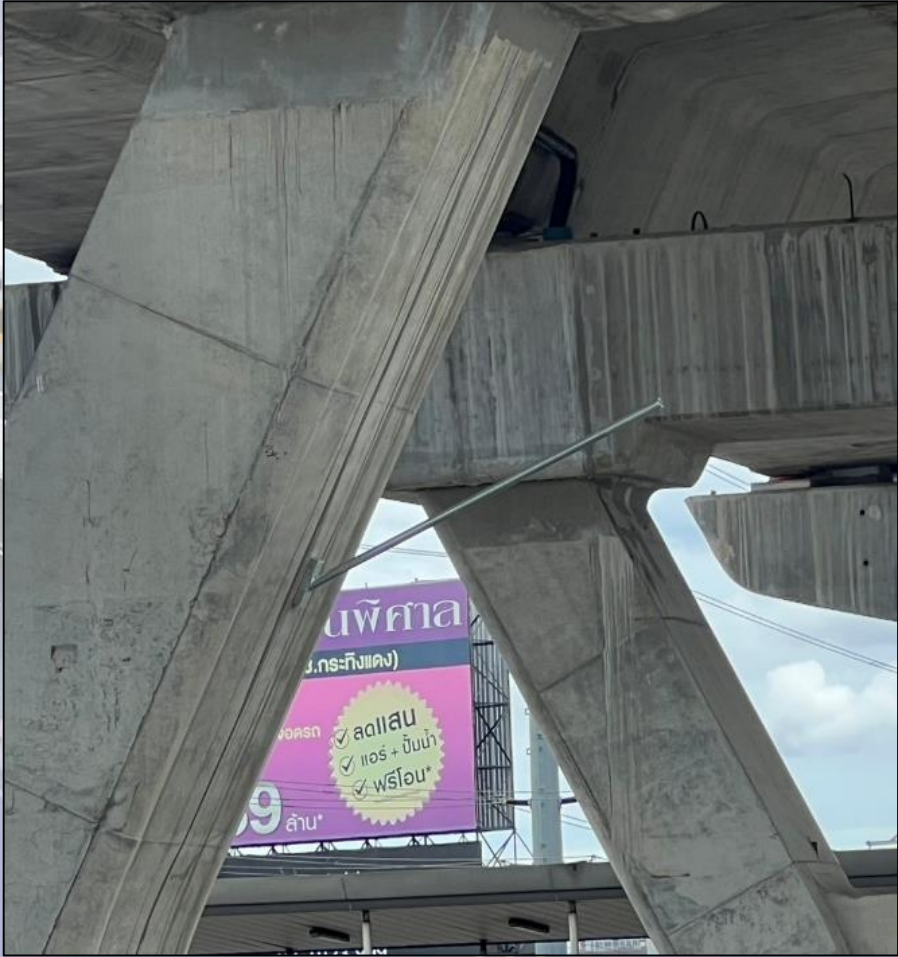
ภาพถ่ายงานติดตั้งเสาไฟถนนแบบกิ่งขาจับเสา Y
