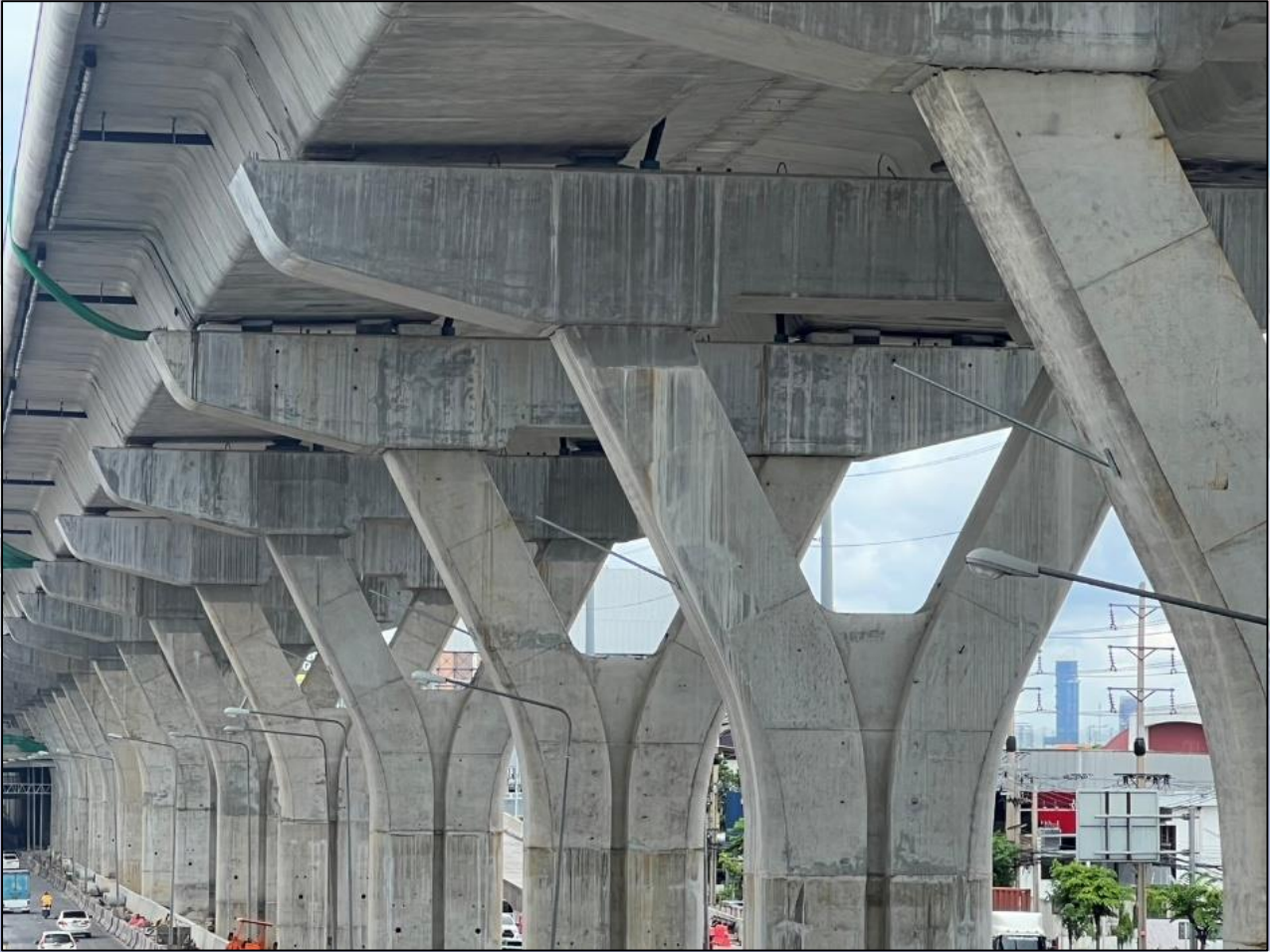
ภาพถ่ายงานติดตั้งเสาไฟถนนแบบกิ่งขาจับเสา Y
