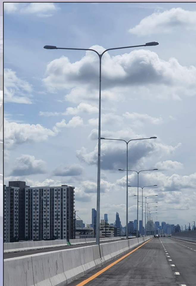
ภาพถ่ายงานติดตั้งเสาไฟถนนแบบกิ่งคู่
