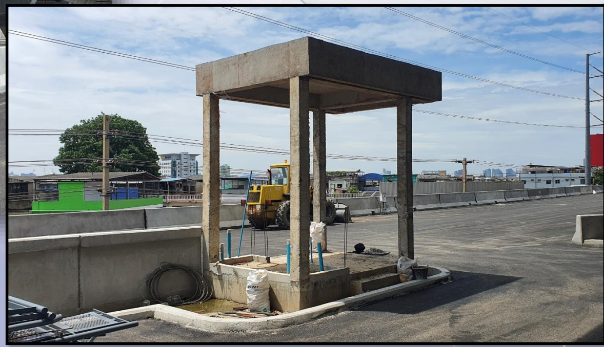
ภาพถ่ายงานก่อสร้างอาคารบริเวณด้านท่าข้าม (Ramp 3)
