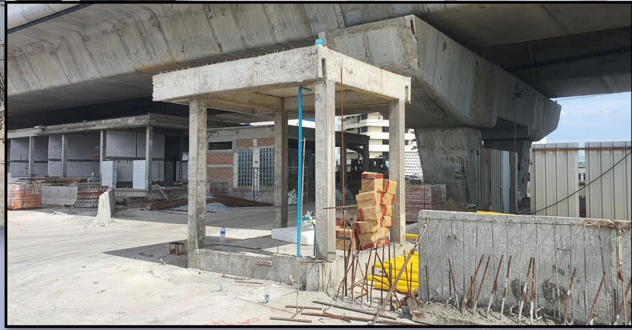
ภาพถ่ายงานก่อสร้างอาคารบริเวณด้านบางมด (Ramp 4)
