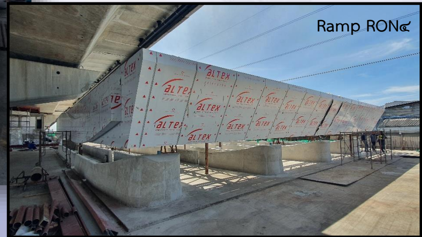
ภาพถ่ายงาน Toll Island and Concrete Barrier – ด้านบางมด (Ramp 4)
