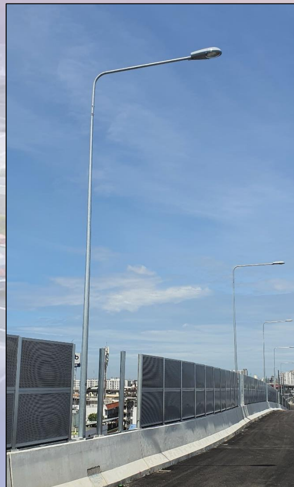
ภาพถ่ายงานติดตั้งเสาไฟถนนแบบกิ่งเดี่ยว
