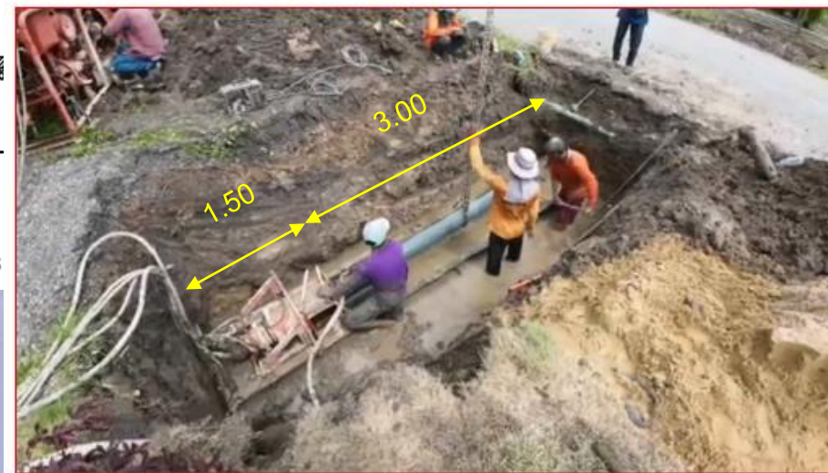
ภาพประกอบตัวอย่างบ่อและเครื่องดันท่อ (STEEL PIPE JACKING )
