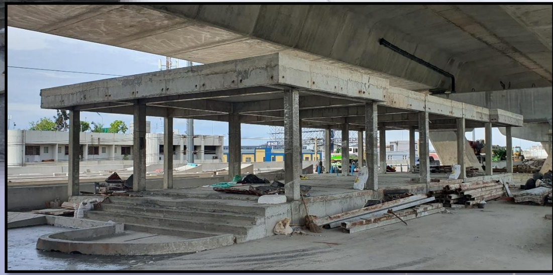
ภาพถ่ายงานก่อสร้างอาคารบริเวณด้านท่าข้าม (Ramp 3)
