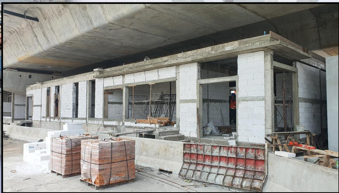
ภาพถ่ายงานก่อสร้างอาคารบริเวณด้านบางมด (Ramp 4)
