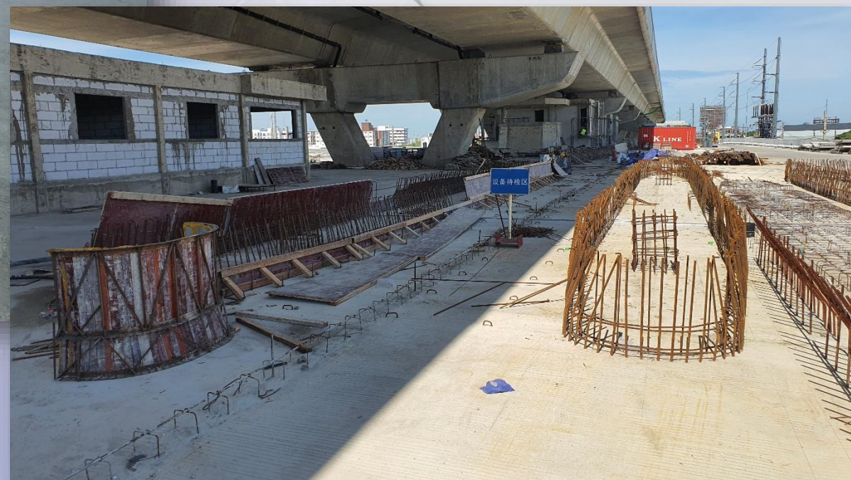
ภาพถ่ายงาน Toll Island and Concrete Barrier – ด้านพุทธบูชา (Ramp 5)
