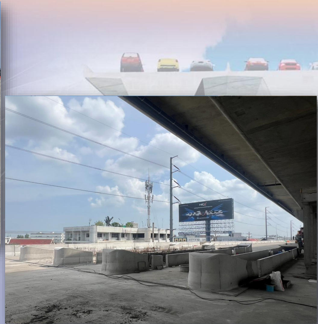
ภาพถ่ายงาน Toll Island and Concrete Barrier – ด้านท่าข้าม (Ramp 3)
