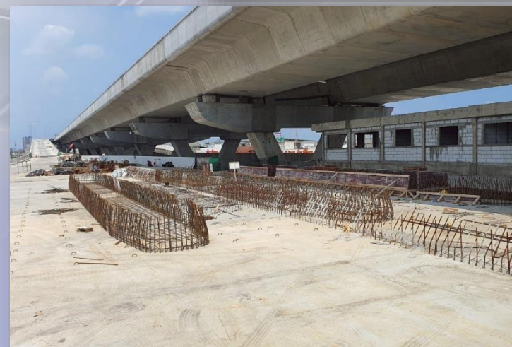
ภาพถ่ายงาน Toll Island and Concrete Barrier – ด้านพุทธบูชา (Ramp 5)
