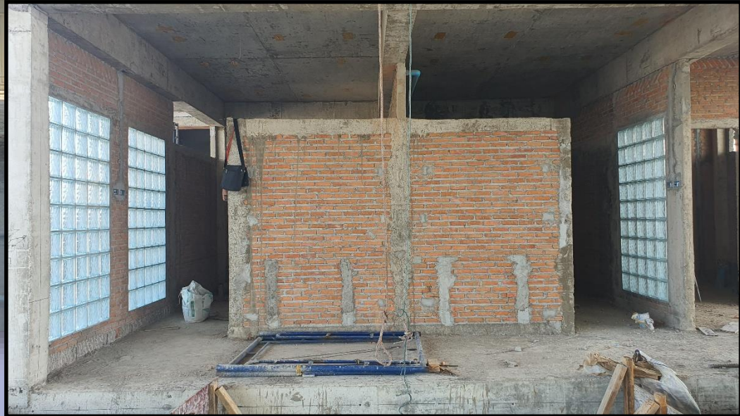
ภาพถ่ายงานก่อสร้างอาคารบริเวณด้านพุทธรูชา (Ramp 5)
