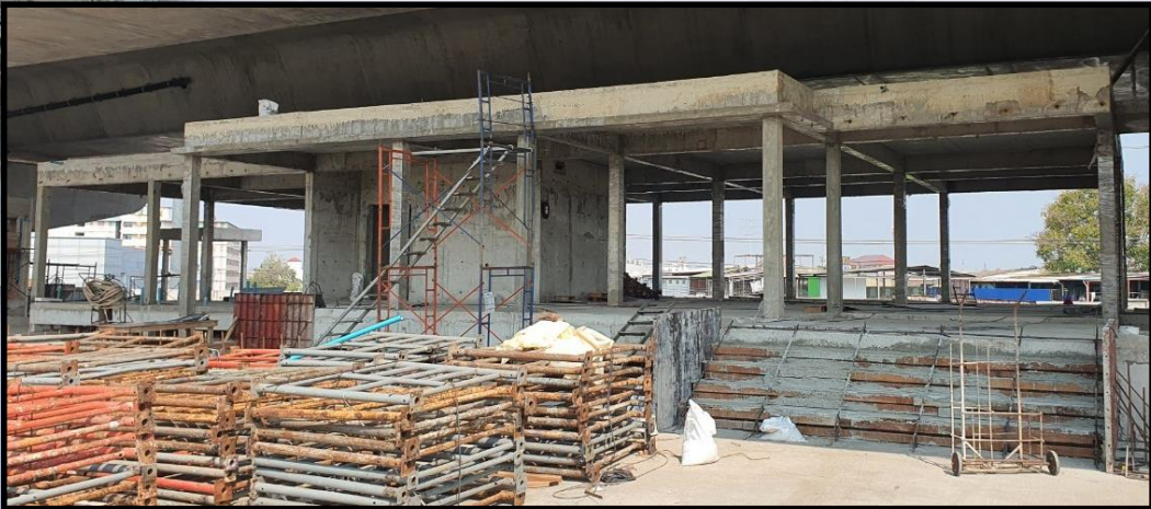
ภาพถ่ายงานก่อสร้างอาคารบริเวณด้านท่าข้าม (Ramp 3)
