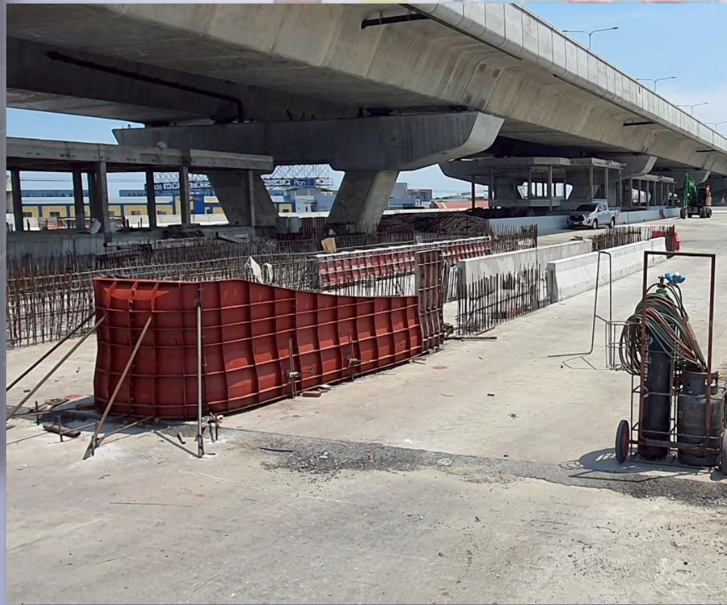
ภาพถ่ายงาน Toll Island and Concrete Barrier – ด้านท่าข้าม (Ramp 3)
