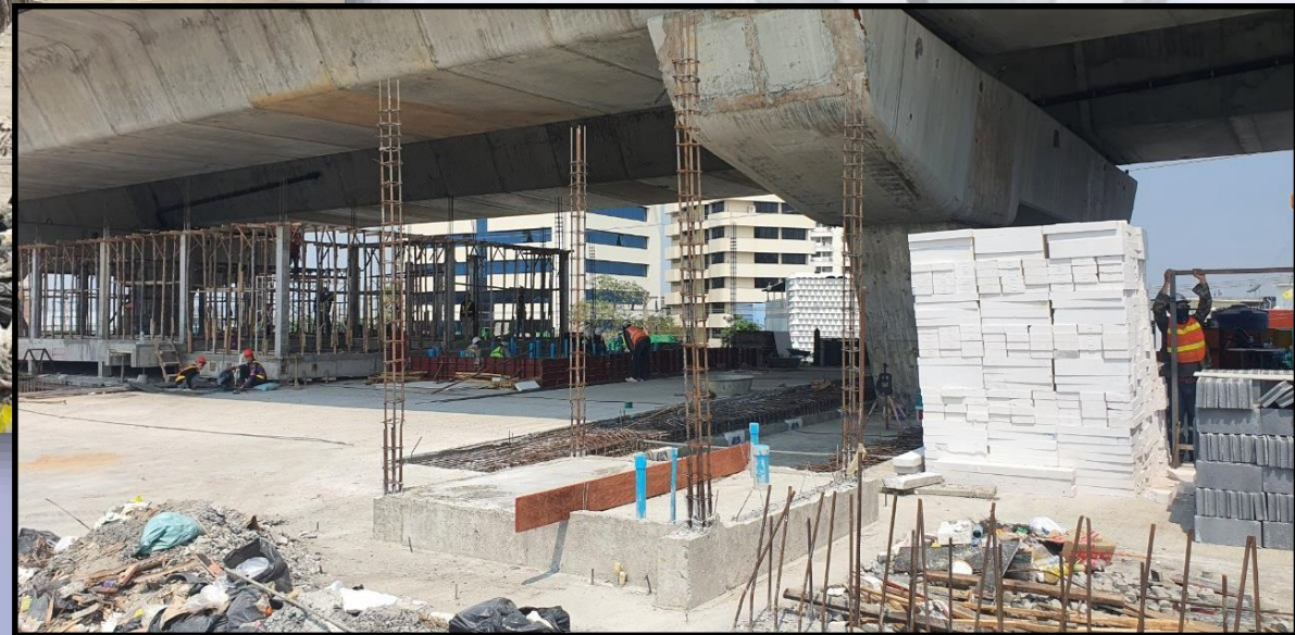
ภาพถ่ายงานก่อสร้างอาคารบริเวณด้านบางมด (Ramp 4)
