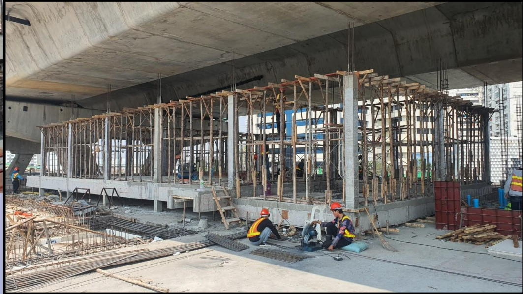
ภาพถ่ายงานก่อสร้างอาคารบริเวณด้านบางมด (Ramp 4)
