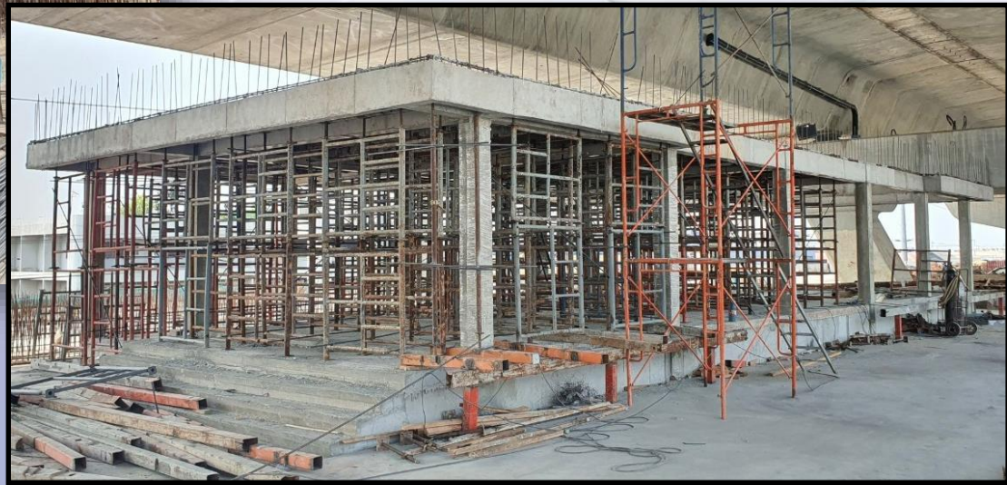
ภาพถ่ายงานก่อสร้างอาคารบริเวณด้านท่าข้าม (Ramp 3)
